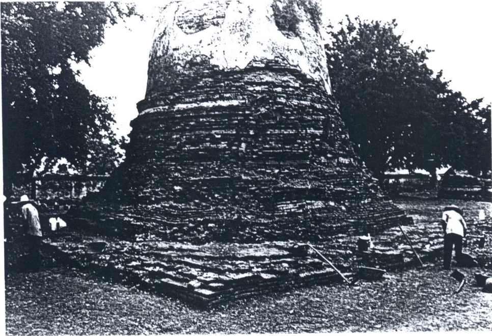
รูปที่ 39 ระหว่างขุดแต่งเจดีย์ราย ( หมายเลข 4 ) ( ฟิล์ม 10/25 )
