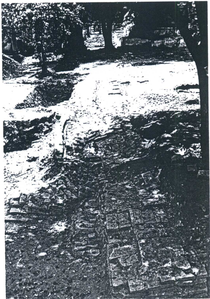
รูปที่ 63 ท่อระบายน้ำที่ออกจากพระอุโบสถมาสู่บ่อพักน้ำ (ฟิล์ม 5/5)
