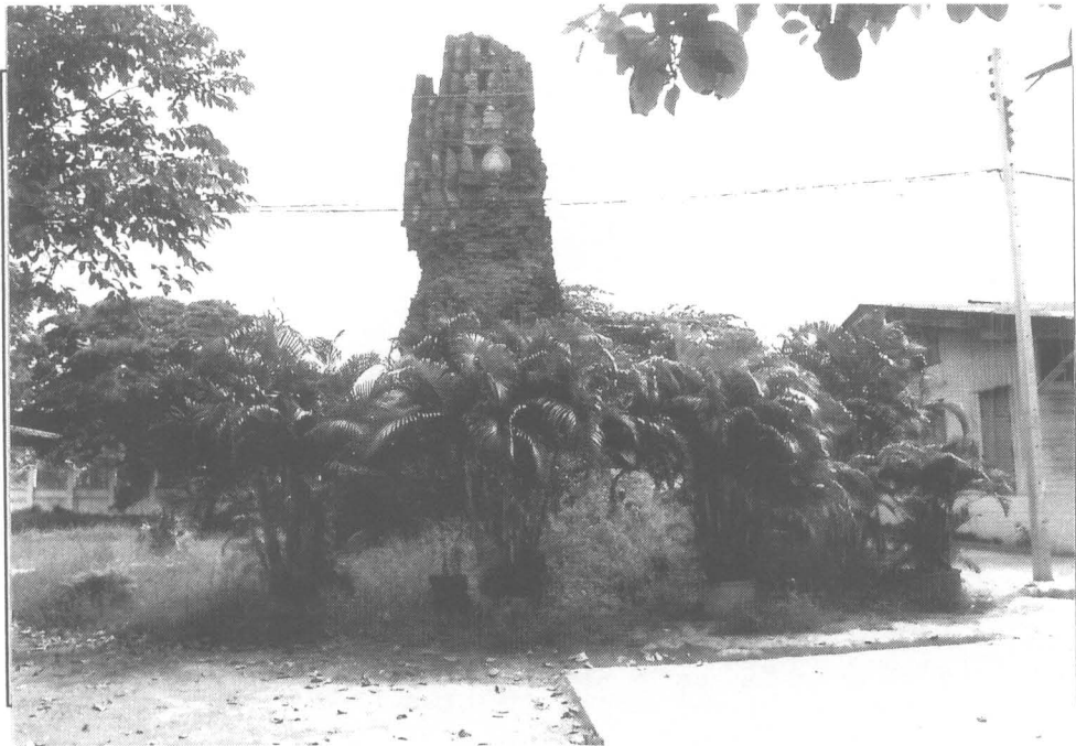
ภาพที่ 2 เจดีย์ทรงปราสาทด้านทิศเหนือ ก่อนดำเนินงาน (ฟิล์มม้วนที่ 1 / 1 )
