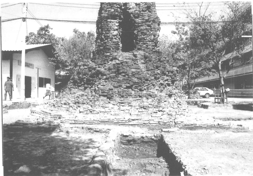
ภาพที่ 24 ลักษณะฐานเจดีย์ทรงปราสาท ด้านทิศใต้หลังขุดแต่ง (ฟิล์มม้วนที่ 5 / 9 )
