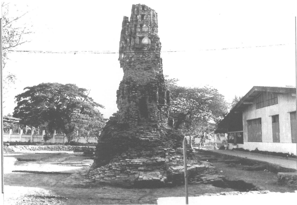
ภาพที่ 22 ลักษณะเจดีย์ทรงปราสาท ด้านทิศเหนือหลังขุดแต่ง (ฟิล์มม้วนที่ 5 / 30 )
