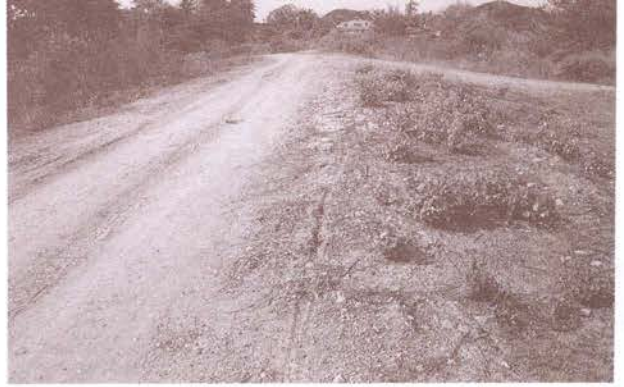
ถนนเหล็ก หรือถนนตลาดเหล็ก ปัจจุบันยังปรากฏร่องรอยของแนวอิฐที่เป็น ส่วนของพื้นถนน
