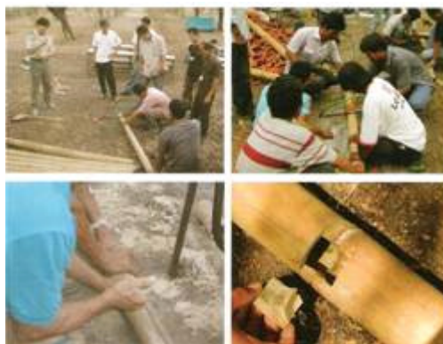
ภาพสร้างปล่องตักน้ำส้มควันไม้ด้วยไม้ไผ่
