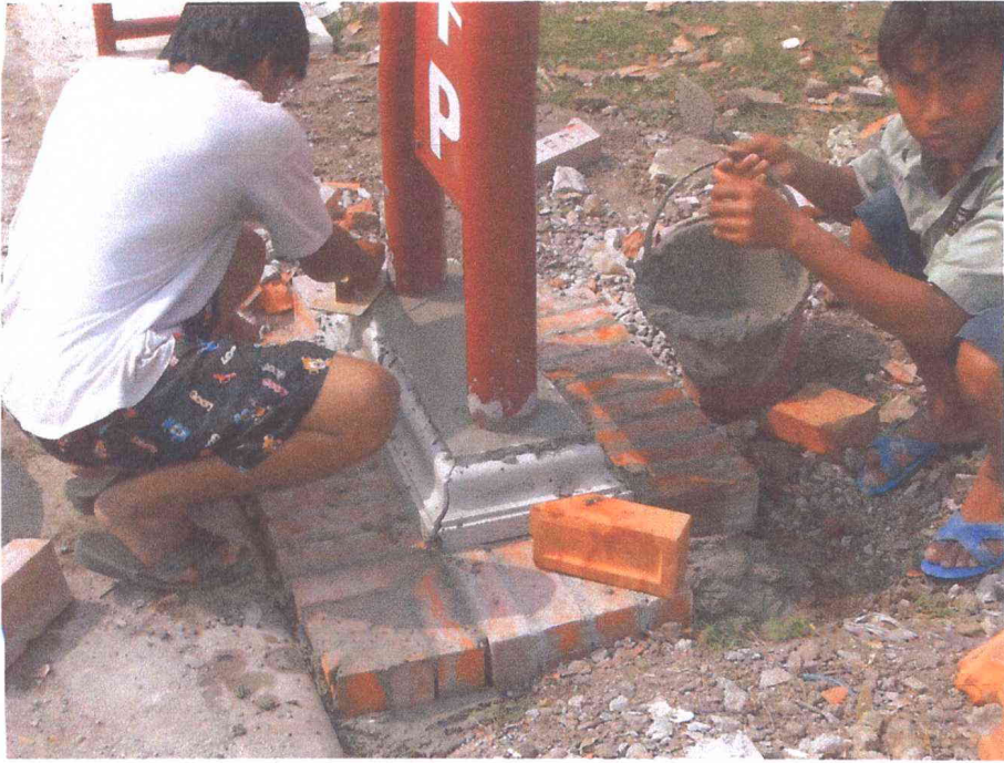
ขณะดำเนินการติดตั้งฐานบัวป้ายที่จอดรถ
