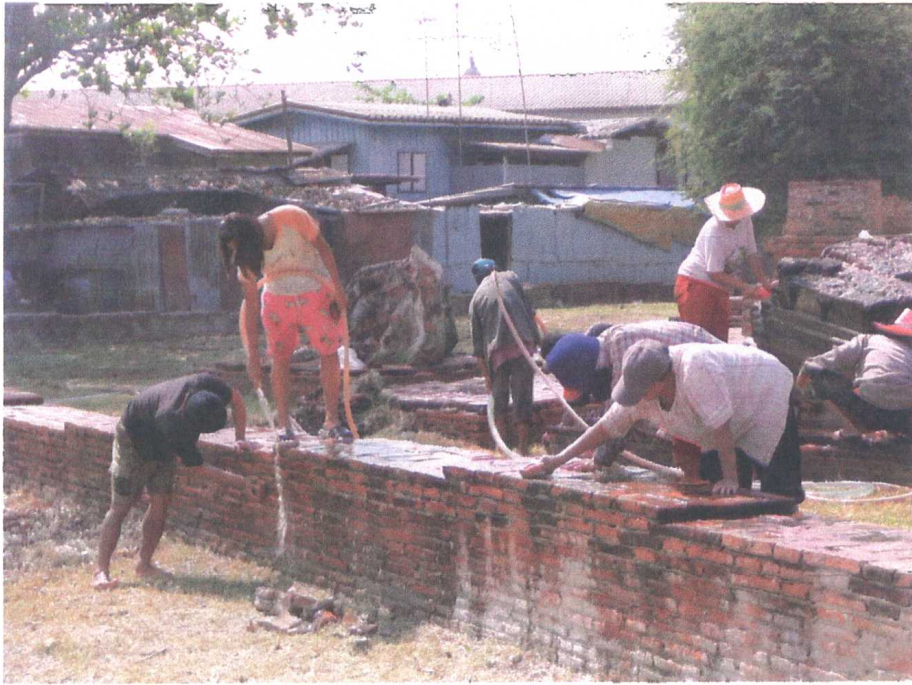
ขณะดำเนินการทำความสะอาดผิวปูนฉาบและผิวอิฐเดิม
