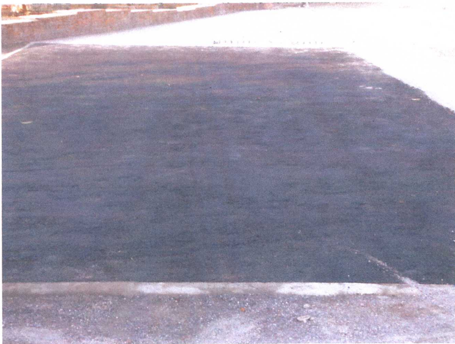
สภาพหลังการเทพื้นแอสฟัลท์พื้นที่จอดรถ
