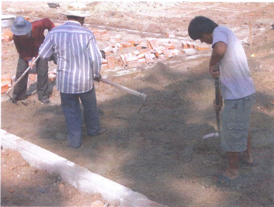
ขณะดำเนินการวางคาน ค.ส.ล.สำเร็จรูป
