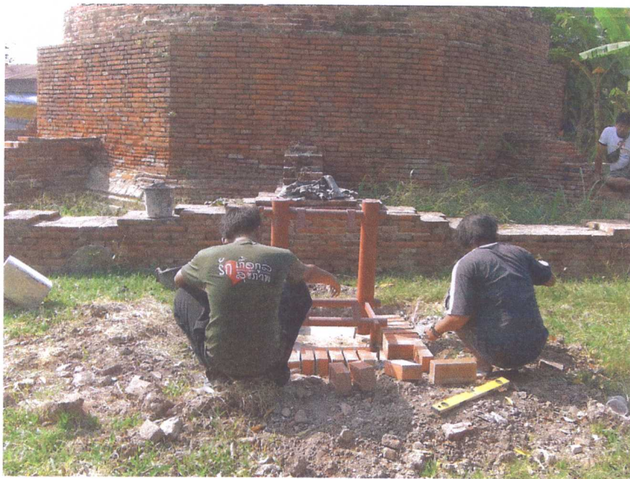
ขณะดำเนินการติดตั้งโครงสร้างเหล็กป้ายบรรยายขนาดเล็ก
