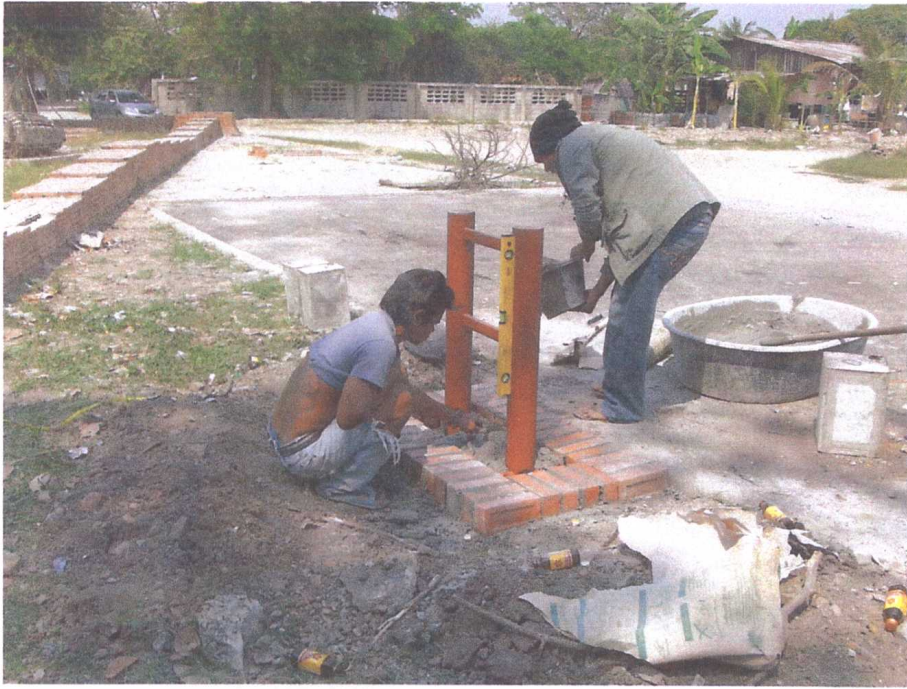
ขณะดำเนินการติดตั้งโครงเหล็กป้ายที่จอดรถ
