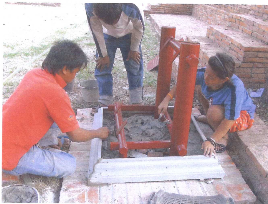
ขณะดำเนินการติดตั้งโครงสร้างเหล็กป้ายบรรยายขนาดเล็ก
