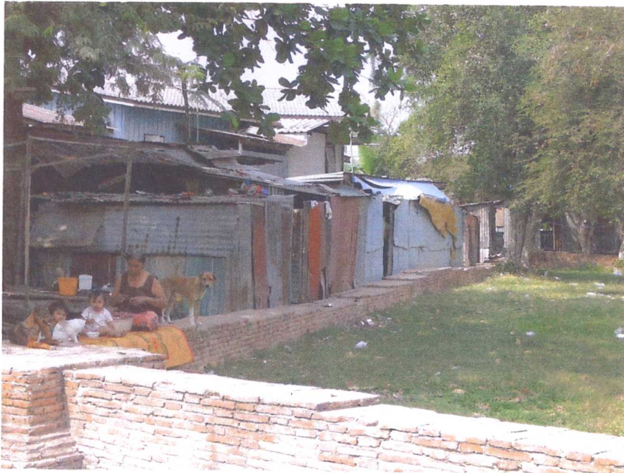
สภาพก่อนทำการรื้อถอนอาคารหรือสิ่งก่อสร้างที่ล้ำเข้ามาในเขตโบราณสถาน
