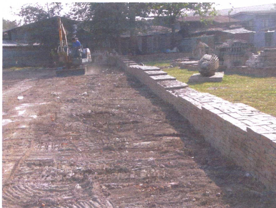
ดำเนินการปรับพื้นที่ก่อสร้างพื้นทางเท้าและที่จอดรถ
