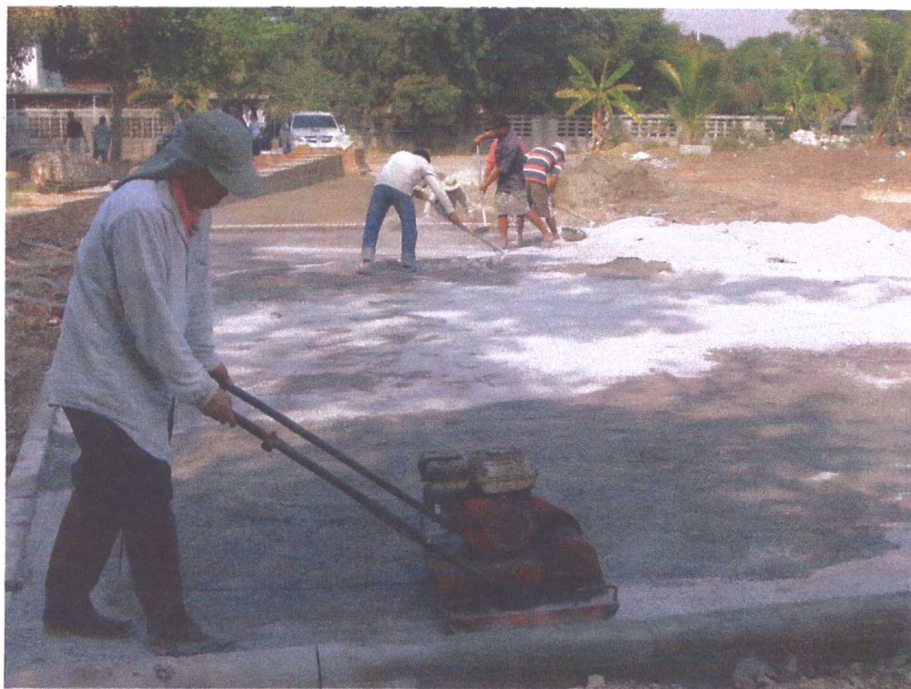
ขณะดำเนินการปรับพื้นที่ด้วยหินเกล็ดบดอัดแน่นพื้นที่จราจร
