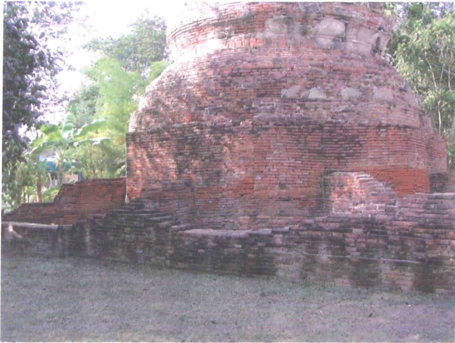
สภาพก่อนทำความสะอาดผิวปูนฉาบและผิวอิฐเดิม
