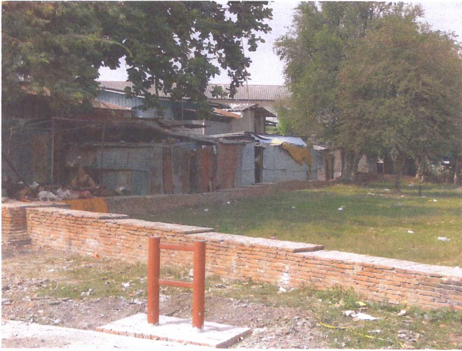
สภาพก่อนทำการรื้อถอนอาคารหรือสิ่งก่อสร้างที่ล้ำเข้ามาในเขตโบราณสถาน
