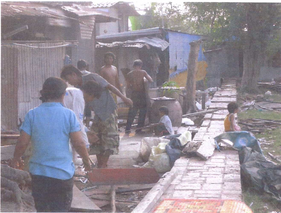
ขณะทำการรื้อถอนอาคารหรือสิ่งก่อสร้างที่ล้ำเข้ามาในเขตโบราณสถาน
