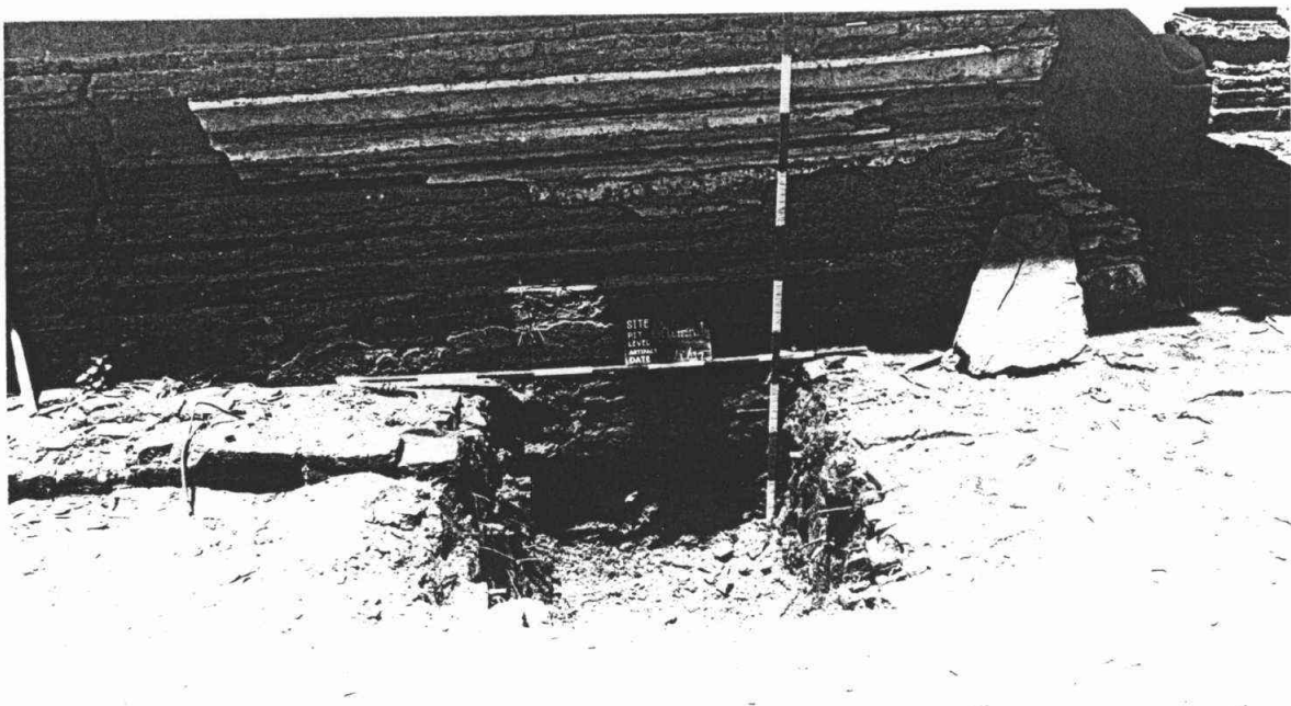
รูปที่ 142 หลุมขุดตรวจฐานรากอุโบสถ
