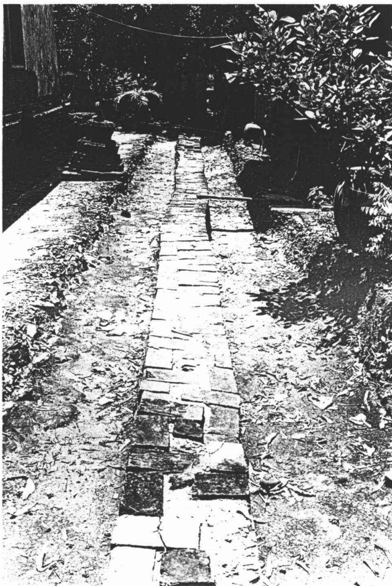
รูปที่ 95 กำแพงแก้วด้านทิศตะวันตกหลังการดำเนินงาน
