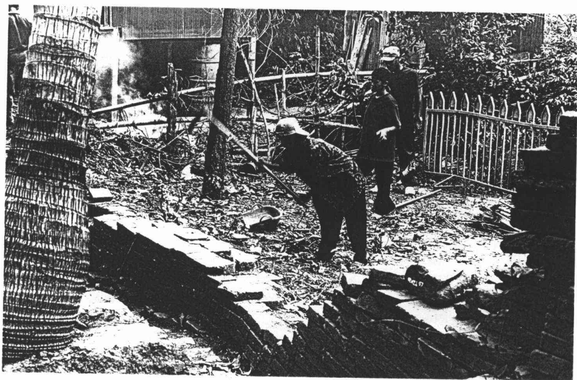
รูปที่ 52 ขณะดำเนินงานบริเวณกำแพงแก้วด้านทิศตะวันตก
