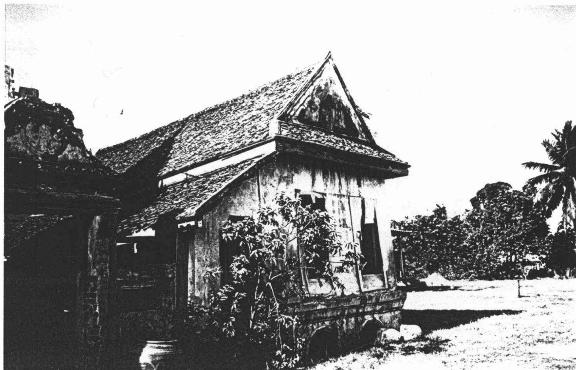
รูปที่ 33 กุฏิหรือศาลาว่างด้านทิศตะวันออกของศาลาการเปรียญก่อนการดำเนินงาน
