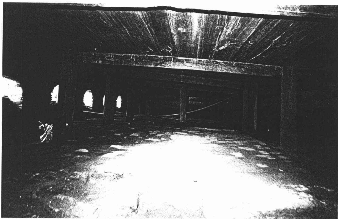
รูปที่ 79 ได้ถุนศาลาการเปรียญหลังชุดลอกดินพบว่าปูพื้นด้วยอิฐ
