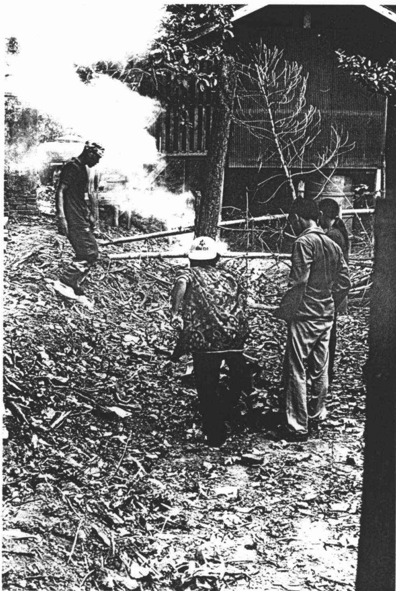
รูปที่ 53 ขณะดำเนินงานบริเวณกำแพงแก้วด้านทิศตะวันตก
