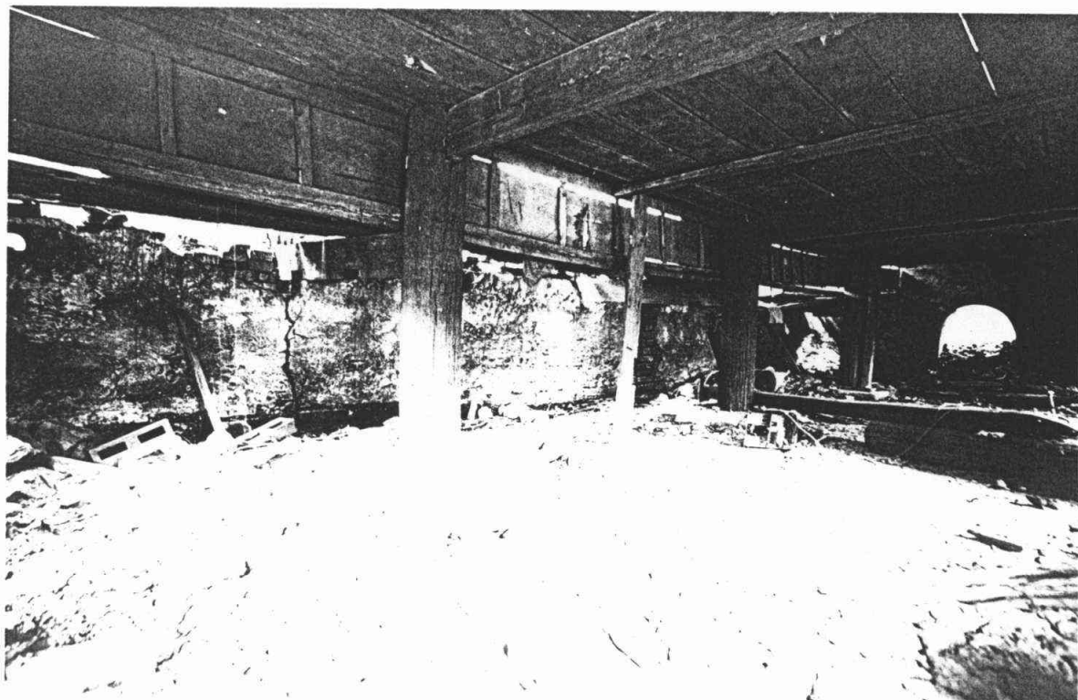
รูปที่ 77 ได้ถุนกฏิหรือศาลาขวางก่อนการดำเนินงาน
