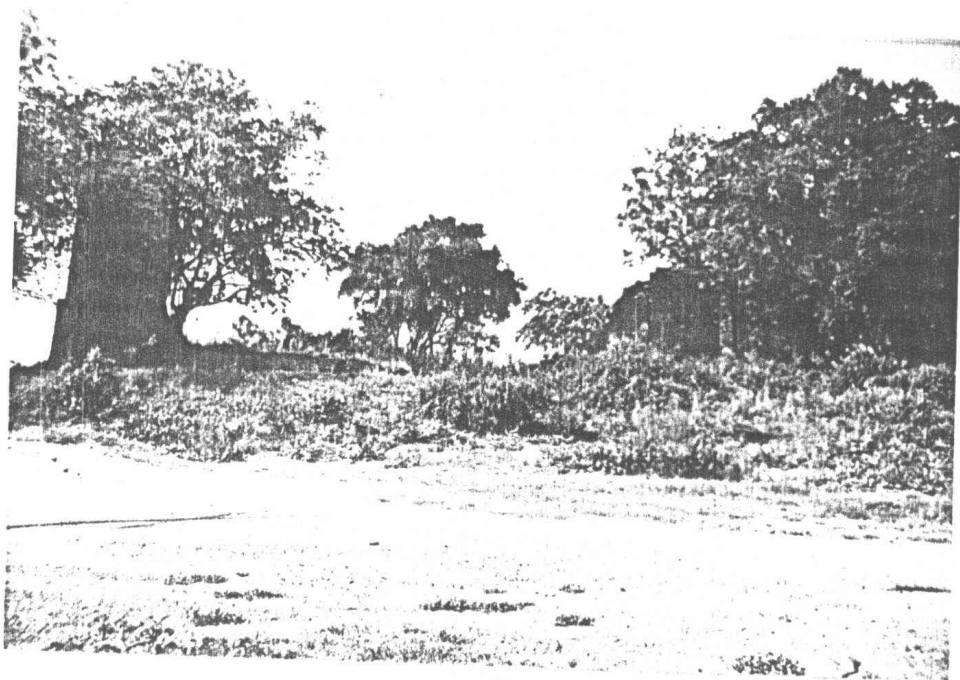
ภาพที่ 41 อุโบสถสภาพก่อนการขุดแต่งมีผนังเหลืออยู่เล็กน้อย (ฟิล์ม 2/19)
