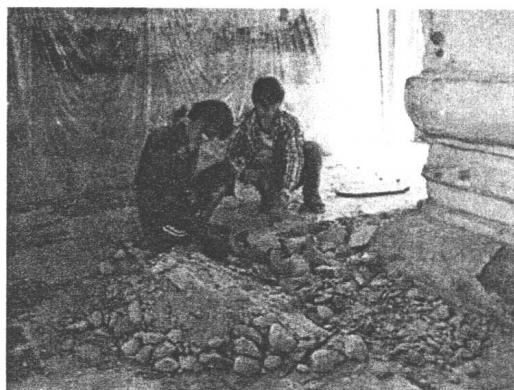
ภาพที่ 25 ขณะทำการรื้อสกัดพื้นเดิมภายในอาคารออก
