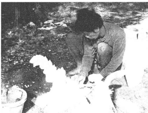
ภาพที่ 16 ดำเนินการถอดพิมพ์เครื่องประดับหลังคา
