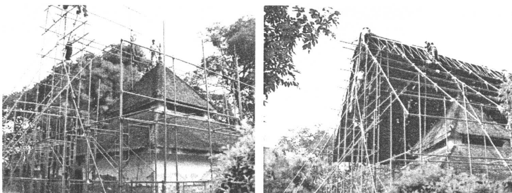
ภาพที่ 8 ดำเนินการติดตั้งนั่งร้านโดยรอบมณฑป
