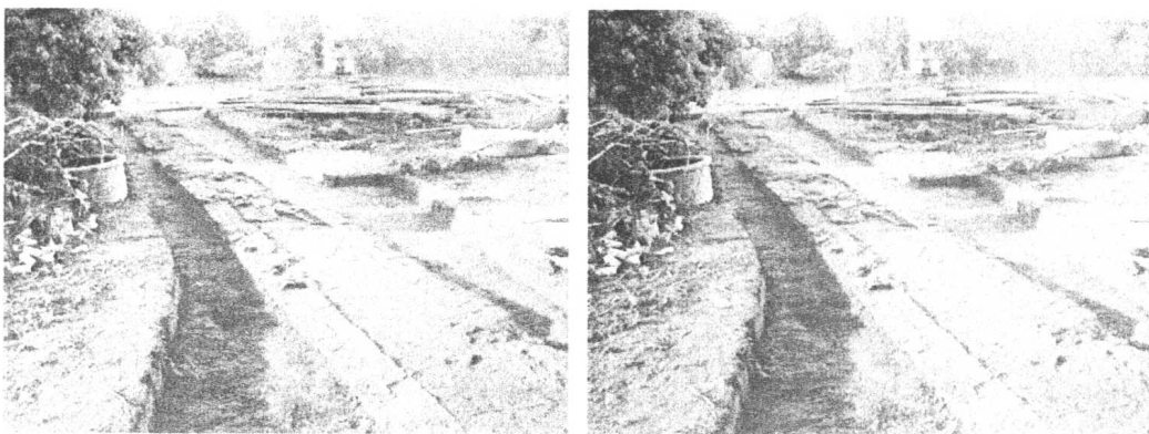
ภาพที่ 7 ถนนทางเดิน ก่อนดำเนินการบูรณะ
