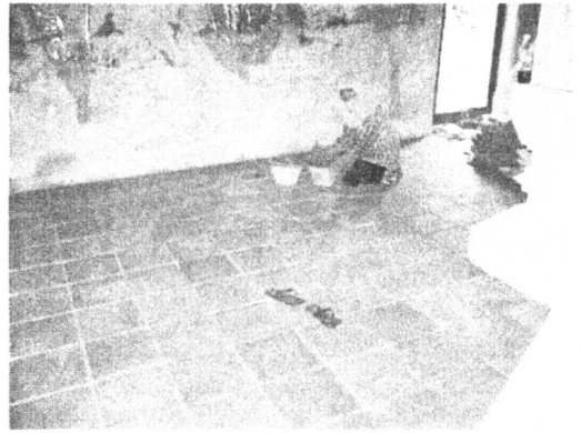
ภาพที่ 28 การบูรณะพื้นปูกระเบื้องดินเผาขนาด 6 \times 6 นิ้ว ภายในอาคาร
