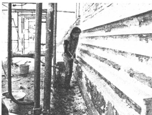
ภาพที่ 19 ดำเนินการฉาบปูนผนังอาคาร
