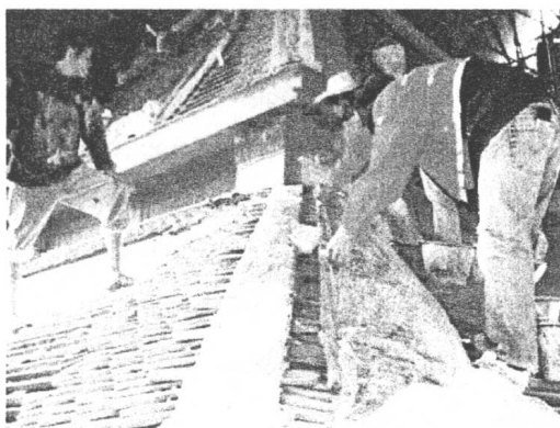
ภาพที่ 14 สันหลังคาและหลบข้างกระเบื้อง
