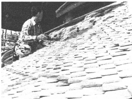
ภาพที่ 15 ขณะมุงกระเบื้องหลังคา
