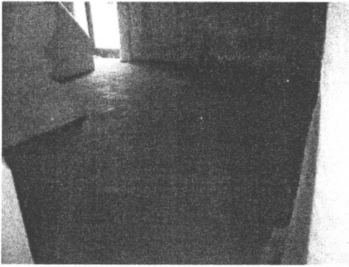
ภาพที่ 28 การบูรณะพื้นปูกระเบื้องดินเผาขนาด 6 \times 6 นิ้ว ภายในอาคาร
