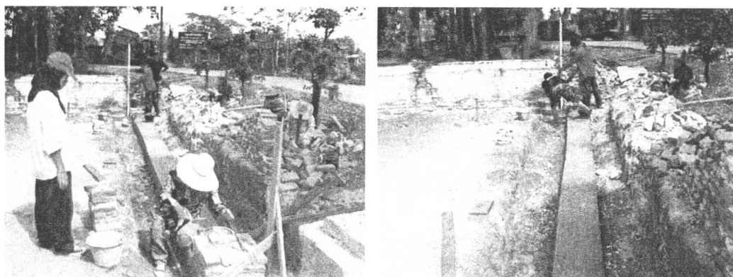
ภาพที่ 31 คาน ค.ส.ล. บริเวณฐานกำแพงแก้ว
