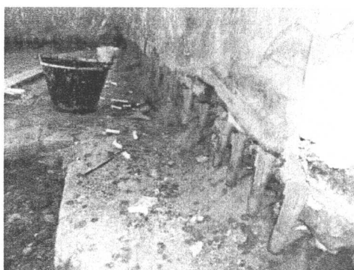
ภาพที่ 20 ดำเนินการตัดความชื้นผนังภายในอาคาร
