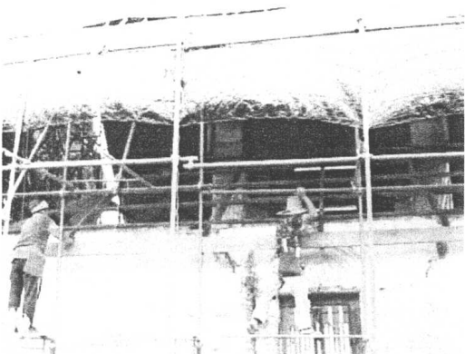
ภาพที่ 13 ขณะทำการติดตั้งไม้เชิงชาย
