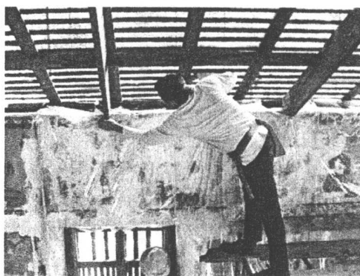
ภาพที่ 18 นำแผ่นพลาสติกใส่คลุมภาพจิตรกรรมฝาผนังเพื่อป้องกันความเสียหาย
