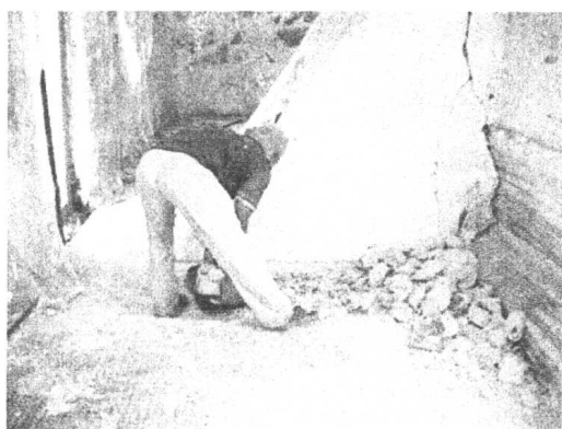
ภาพที่ 25 ขณะทำการรื้อสกัดพื้นเดิมภายในอาคารออก
