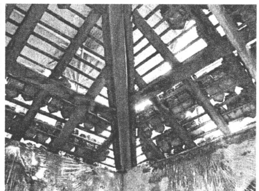
ภาพที่ 11 สภาพภายในโครงสร้างหลังคา หลังทำการรื้อกระเบื้องมุงหลังคาออก
