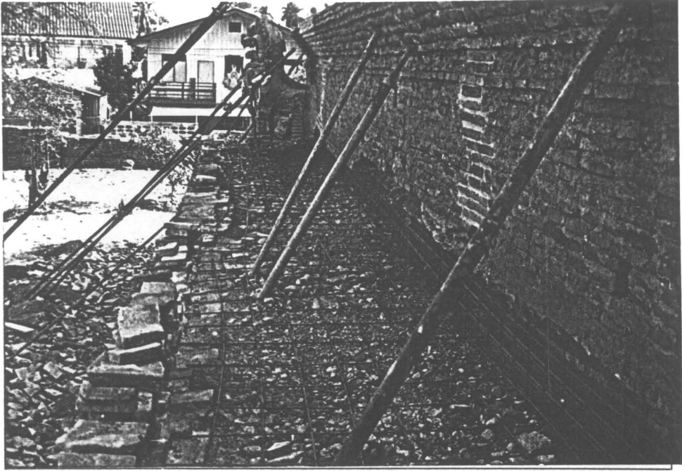
รูปที่ 77 วางเหล็กเทคาน ค.ส.ล. ชั้นรองรับสิ่งปูผนัง (4/12)
