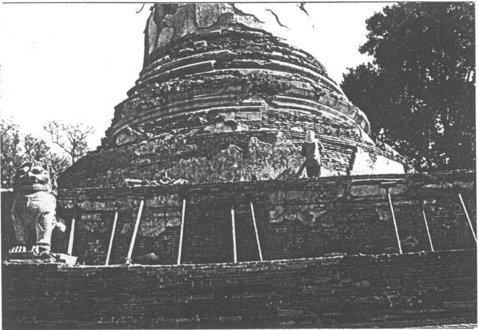
รูปที่ 76 ขณะบูรณะฐานเจดีย์ประธาน (3/22)
