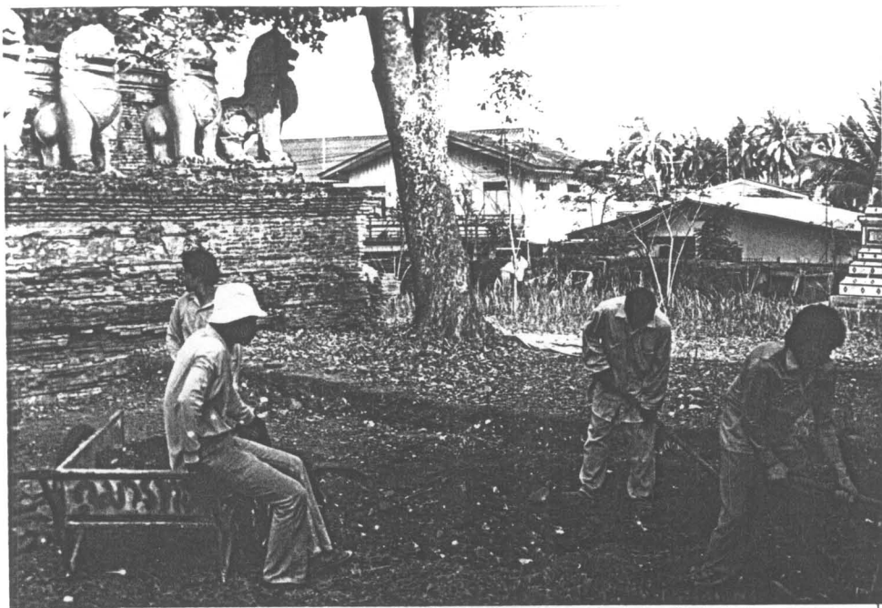
รูปที่ 5 เจดีย์ประธาน ขณะทำการขุดแต่ง (2/0)
