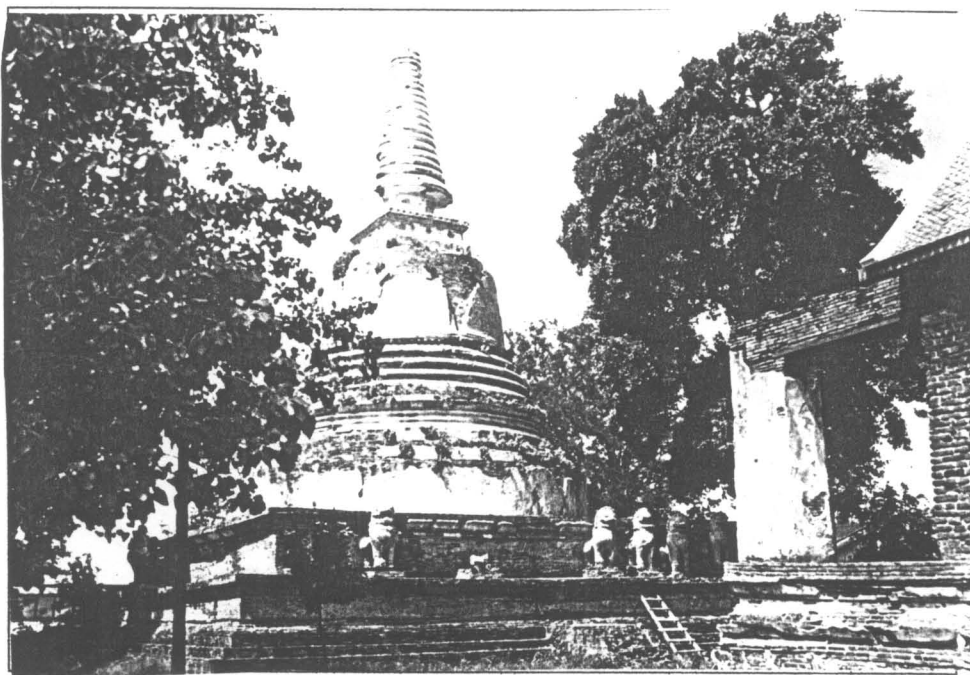
รูปที่ 80 เจดีย์ประธาน ภายหลังการบูรณะ
