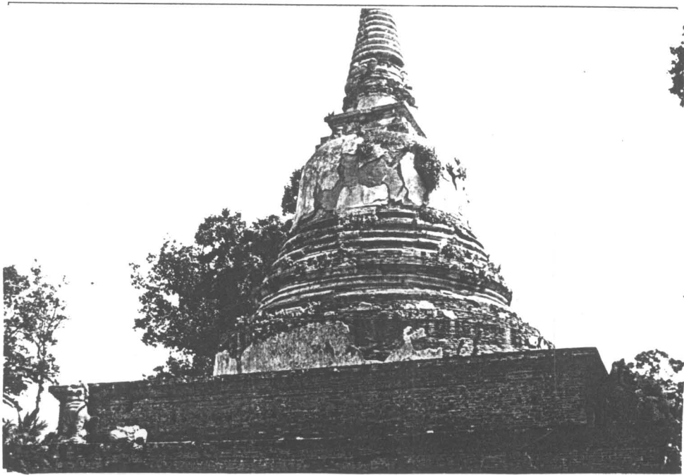
รูปที่ 81 เจดีย์ประธานภายหลังการบูรณะ
