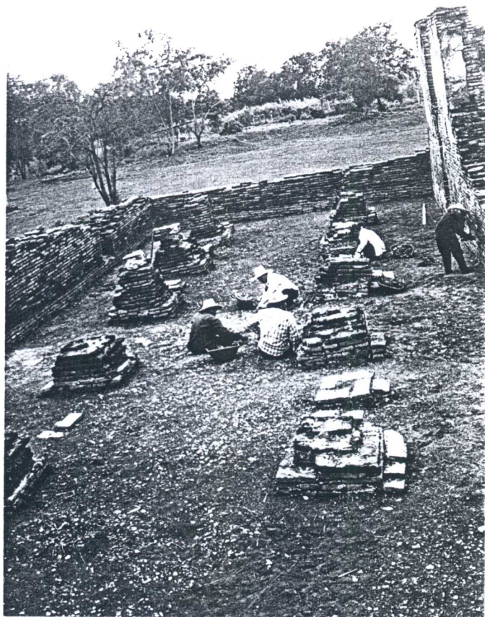
รูปที่ 27 เสาภายในอาคาร หลังการขุดแต่ง फिल्मที่ (4/29)
