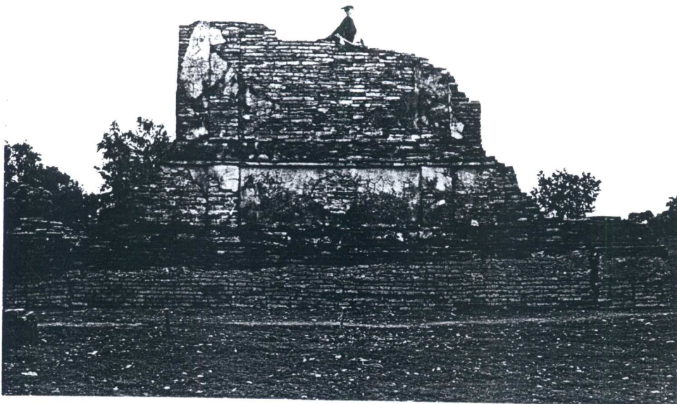
รูปที่ 26 ผนังภายนอกด้านทิศตะวันตก พิล์มที่ (4/27)
