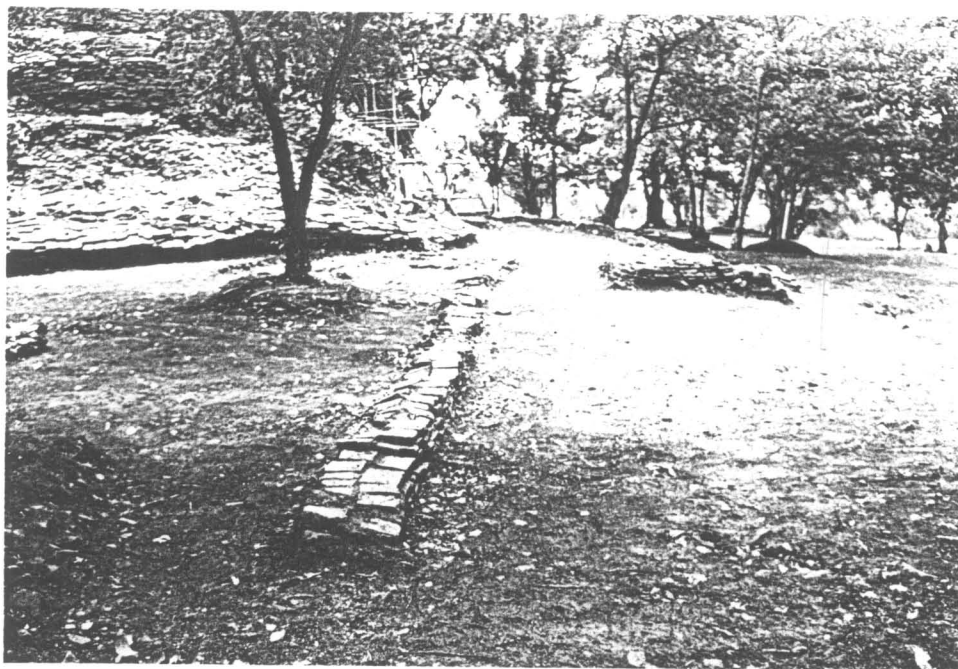
รูปที่ 61 แนวเศษวัสดุที่นำมาเรียงเป็นเอ็นกันดิน (7/31)
