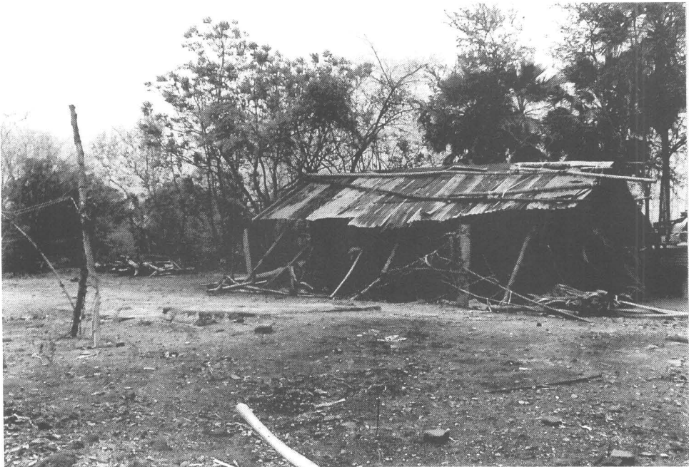
ภาพที่ 8 สภาพก่อนการขุดแต่ง สภาพทั่วไปบนอาคารหมายเลข 1
