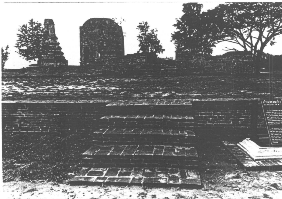
รูปที่ 76 บันไดทำน้ำ ภายหลังจากการบูรณะ(33/22)
