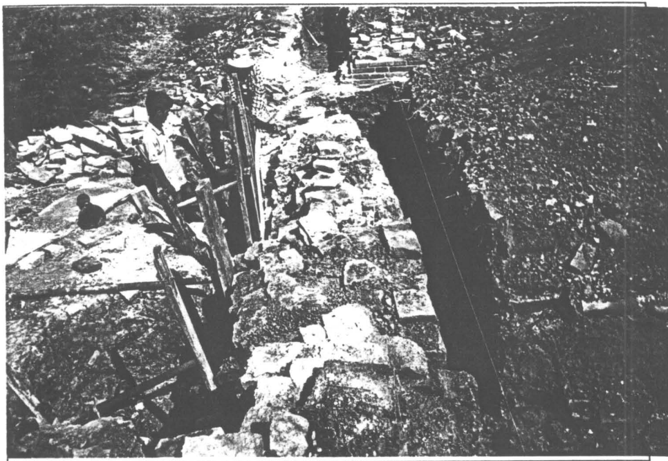
รูปที่ 41 ดำเนินการบูรณะแนวกำแพงแก้ว (22/25)
