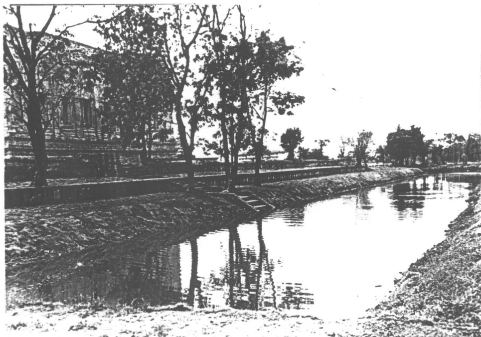
รูปที่ 73 กำแพงกันน้ำกระแทกด้านทิศเหนือ ภายหลังการบูรณะ(33/19)
