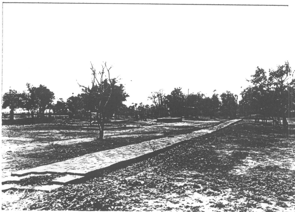
รูปที่ 81 ฐานสิ่งก่อสร้างภายในเขตสังฆาวาส ภายหลังการบูรณะ(33/27)
