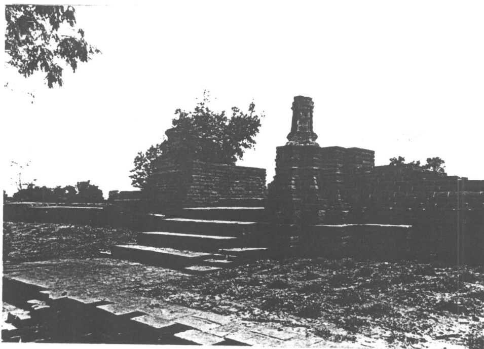
รูปที่ 69 ซุ้มประตูทางเข้าด้านทิศเหนือ ภายหลังการบูรณะ(33/15)
