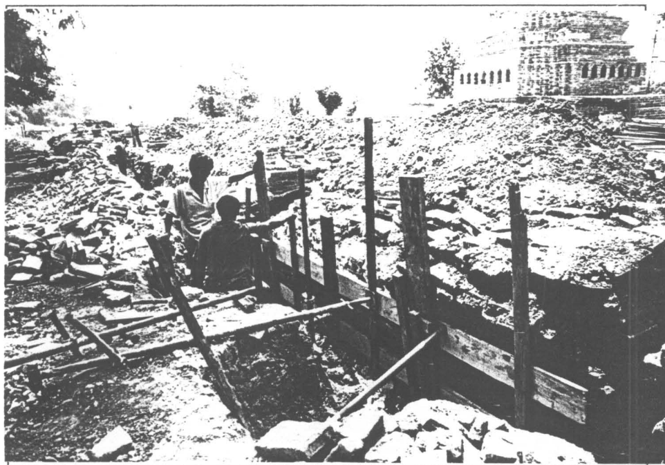
รูปที่ 40 ดำเนินการบูรณะแนวกำแพงแก้ว (13/8)
