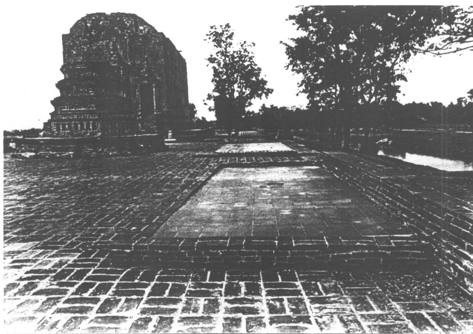
รูปที่ 64 อาคารที่สร้างติดกับแนวกำแพงแก้ว ภายหลังการบูรณะ(33/10)
