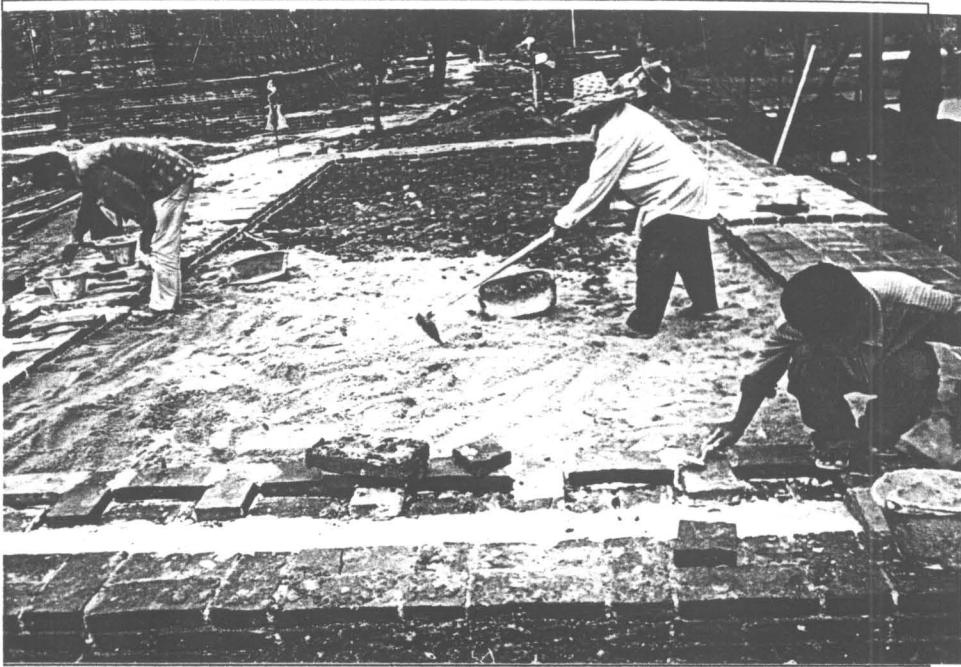
รูปที่ 35 ดำเนินการบูรณะฐานอาคารที่สร้างติดกับแนวกำแพงแก้ว (24/3)
