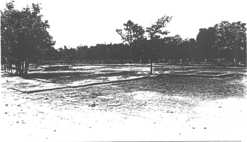
รูปที่ 82 ฐานสิ่งก่อสร้างภายในเขตสังฆาวาส ภายหลังการบูรณะ(33/28)
