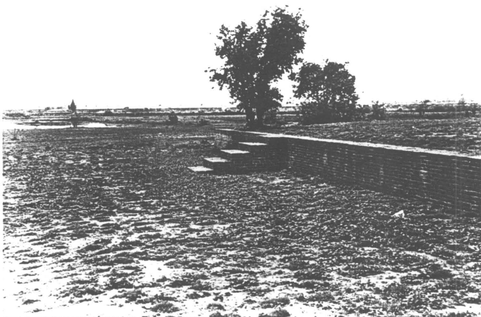
รูปที่ 77 บันไดทำน้ำ ภายหลังจากการบูรณะ(33/23)
