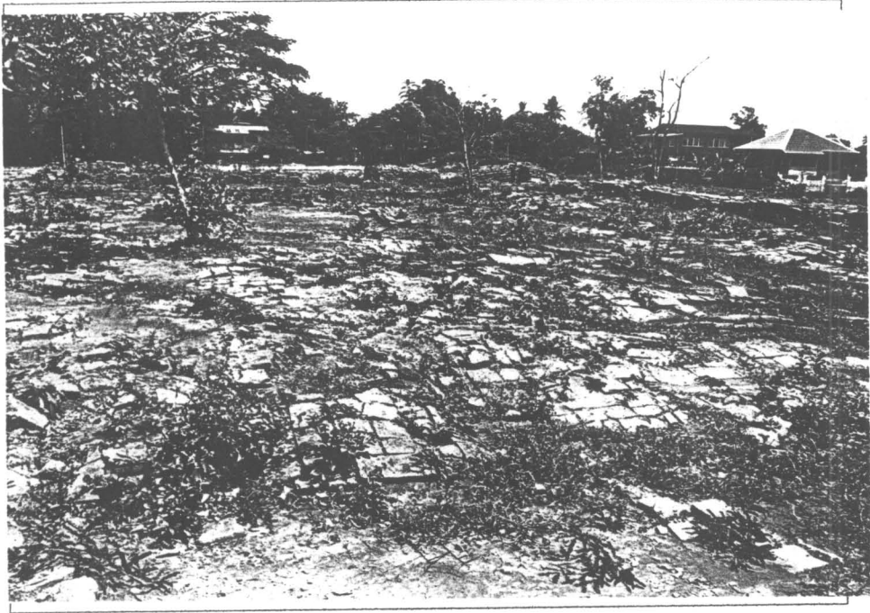
รูปที่ 9 สภาพโดยทั่วไปของตัวอาคาร ก่อนดำเนินการบูรณะ (6/19)
