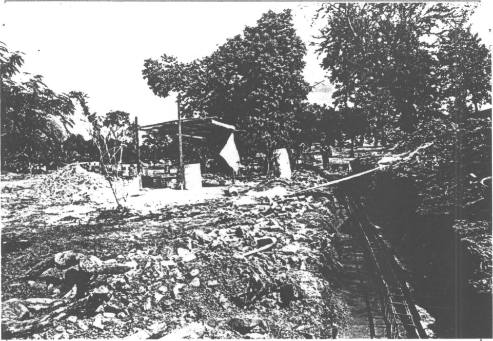
รูปที่ 52 ดำเนินการบูรณะและเสริมความมั่นคงเนินอาคาร (25/4)
