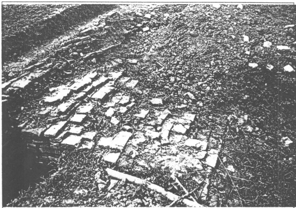
รูปที่ 17 บันไดทำน้ำ ก่อนดำเนินการบูรณะ (13/1)
