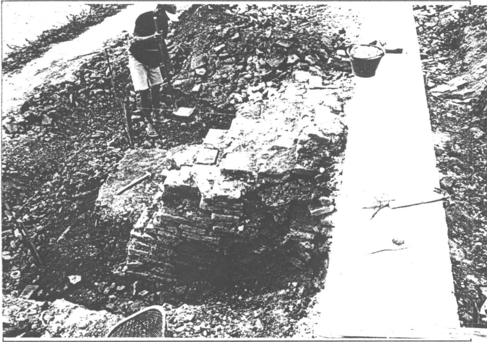
รูปที่ 46 ดำเนินการบูรณะบันไดทำน้ำ (25/25)
