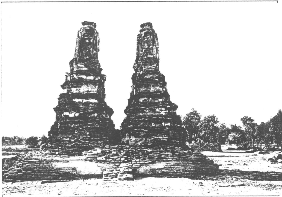
รูปที่ 7 สภาพโดยทั่วไปของเจดีย์ย่อมุม 2 องค์ ด้านหลังอุโบสถ ก่อนดำเนินการบูรณะ (1/17)
