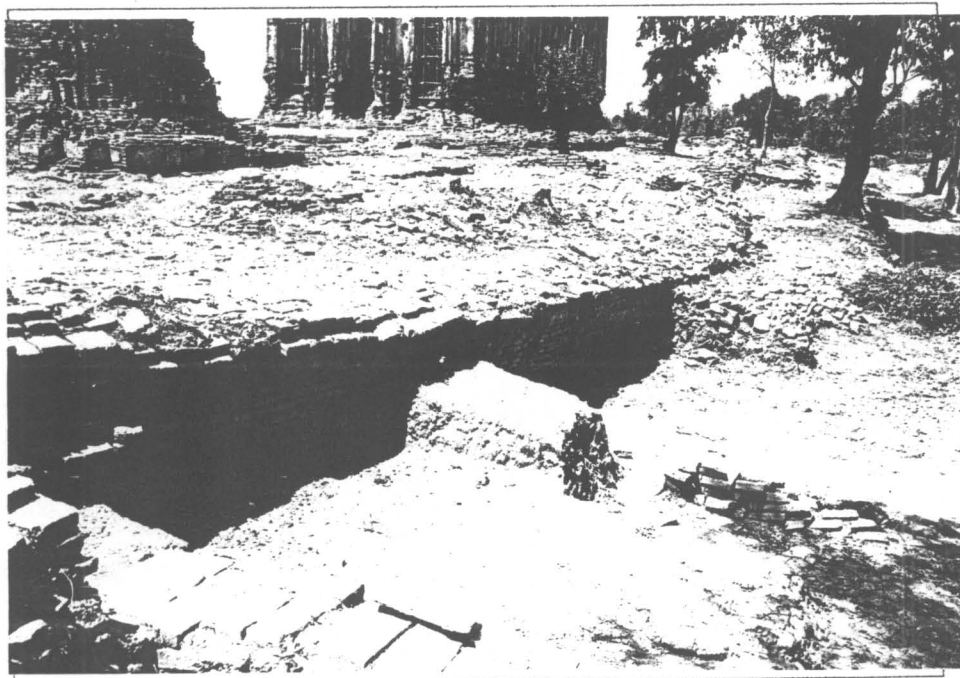
รูปที่ 16 แนวกำแพงกันน้ำกระแทก ก่อนดำเนินการบูรณะ (6/21)
