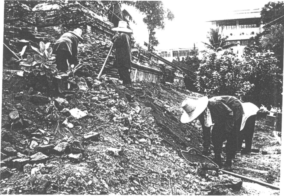
ภาพถ่ายที่ 13 ขณะขุดแต่งฐานเจดีย์ประธานด้านทิศเหนือ
