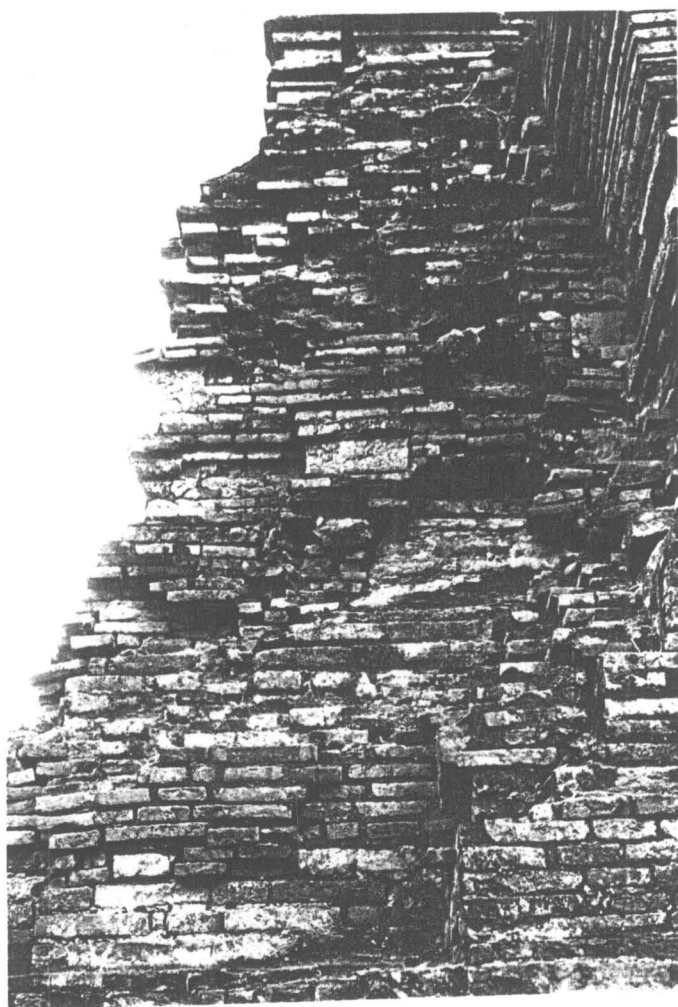
ภาพถ่ายที่ 35 การก่อ พอกทับบริเวณมุขด้าน ทิศใต้ แสดงให้เห็น เทคนิคการถากบัวที่ต่าง กันระหว่างสมัยที่ 2 และ สมัยที่ 3
