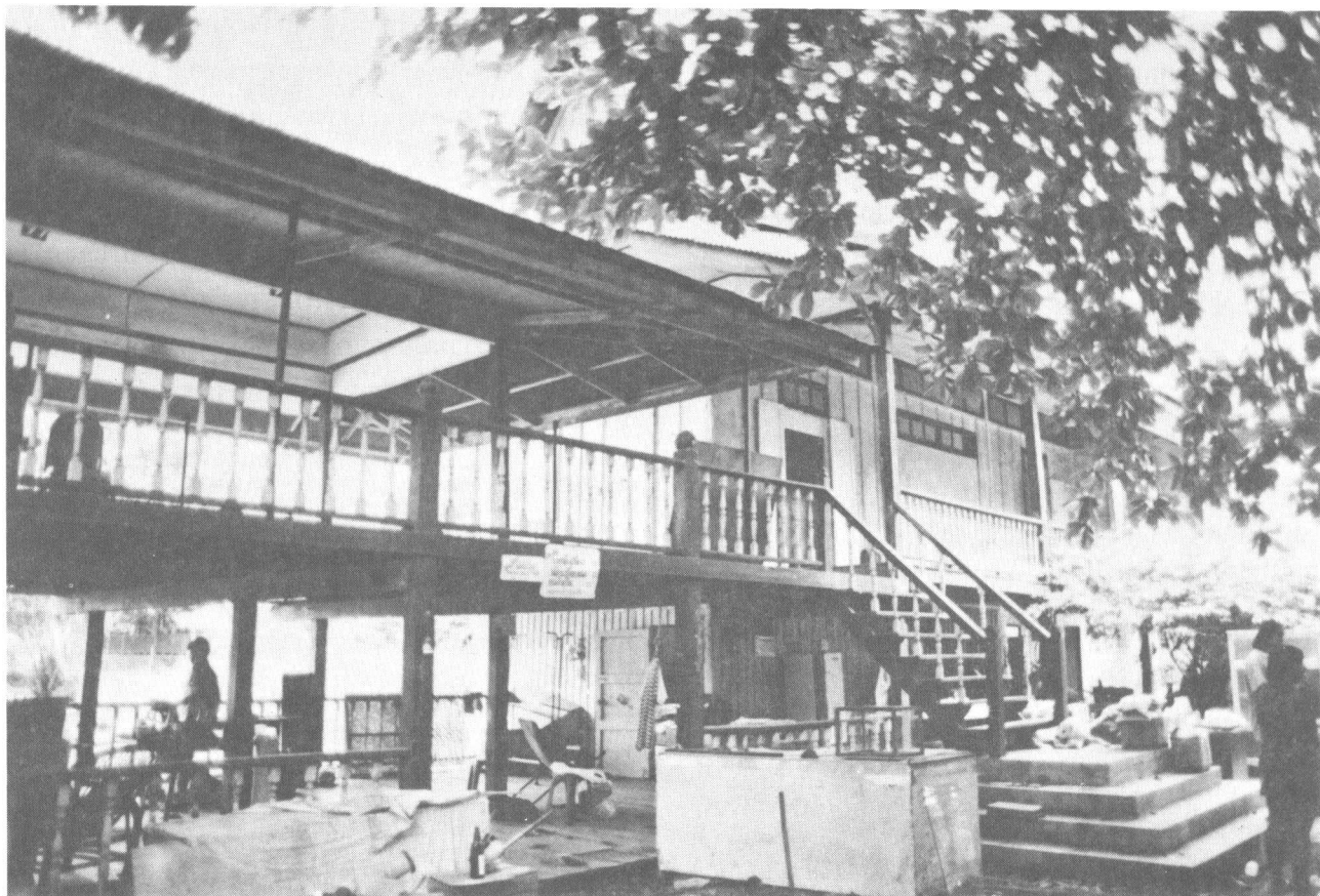
สิ่งก่อสร้างของทางราชการ ซึ่งสำนักงาน ได้ทำการรื้อถอนใน พ.ศ.2539
