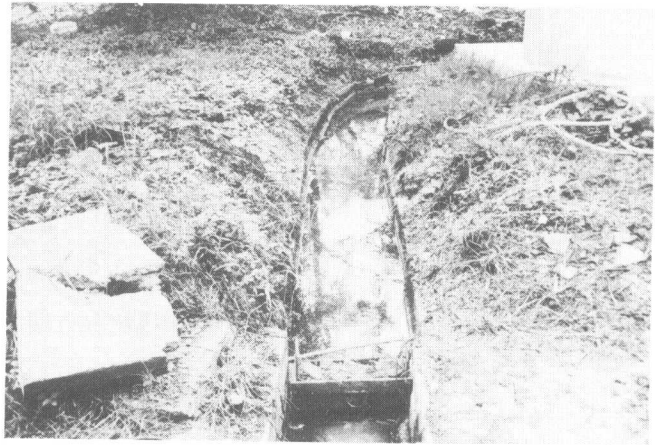
รูป 3 ลักษณะการติดตั้งอุปกรณ์กำจัดเศษอาหารและไขมัน
